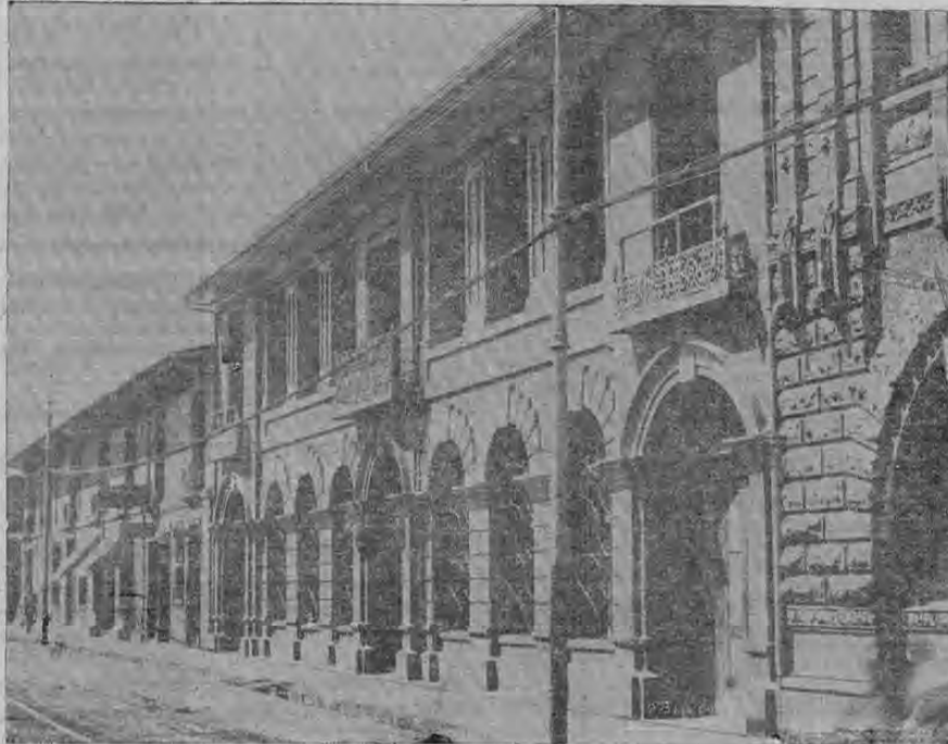
EDIFICIO DEL BANCO COMERCIAL DE COSTA RICA
